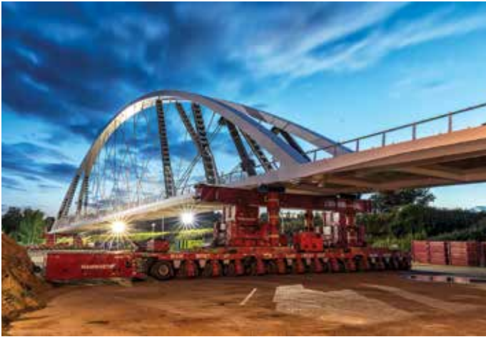
De SPMT's zijn zo dicht mogelijk bij de definitieve steunpunten geplaatst.
