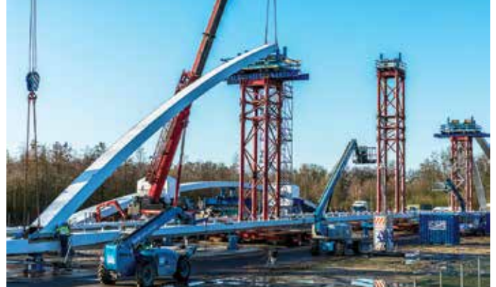
...en daarna ingehesen op drie tijdelijke torens op de voorbouwlocatie.
