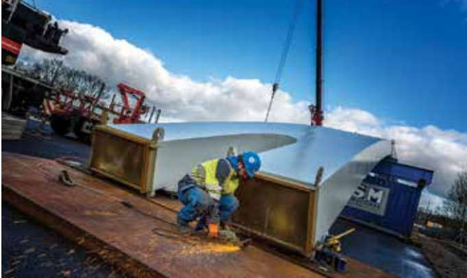
De drie segmenten van de middenboog zijn naast het wegdek aan elkaar gelast....
