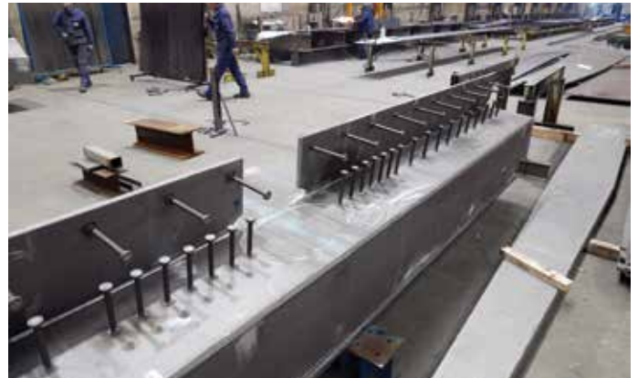
De deuvels tegen zijkant wegdekligger worden toegevoegd op de bouwplaats.
