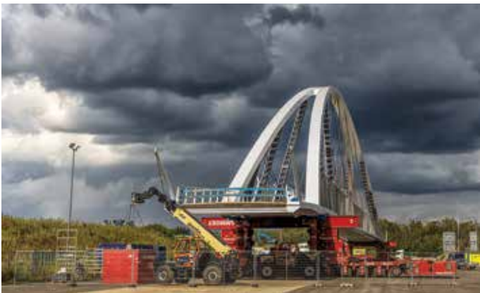
In de week voor inrijden worden de SPMT's gekoppeld tot 2 sets van 2x14 assen.
