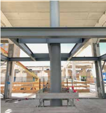
1. Nieuwe stalen kolom.
